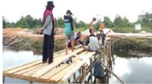
Gambar 4. Proses pembangunan jembatan penghubung ke area wisata Mahali Park oleh tim pengabdian
