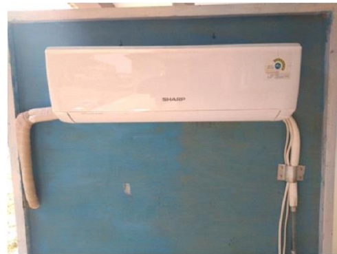
Gambar 4. Penampang depan evaporator
