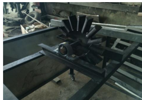
Gambar 4 Pemasangan turbin pelton
